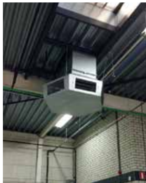
6-stronne plenum nawiewu w 6 kierunkach wyposażone w żaluzje poziome
